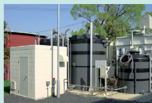
■ 株式会社島津製作所 10m 3 /日厨房&洗浄油排水処理設備 備 鉛物油の混じる洗浄水も同時処理
