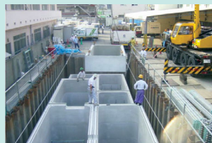
■ 川崎食品産業株式会社 排水処理設備工事風景 40m 3 ユニット槽×7槽
