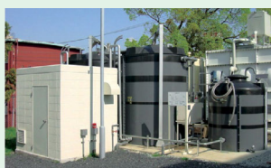
■ 株式会社島津製作所 10m 3 /日厨房&洗浄排水処理設備 鉍物油の混じる洗浄水も同時処理 島津製作所 社内環境賞を受賞!!
