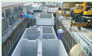
■ 川崎食品産業株式会社 排水処理設備工事風景 40m 3 ユニット槽×7槽
