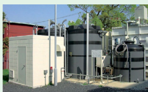
■ 株式会社島津製作所 10m 3 /日厨房&洗浄排水処理設備 鉍鉛物油の混じる洗浄水も同時処理 島津製作所 社内環境賞を受賞!!
