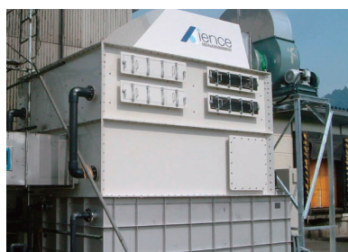
■ 焼鳥工場排ガス処理 (FRP+SUS仕様)
