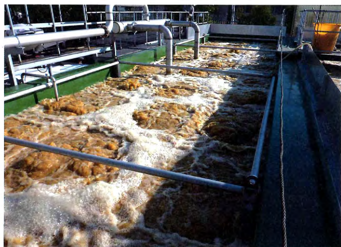
アクアプラスターの稼働中の様子。規則的な泡によって浄化槽内の汚水が循環している
