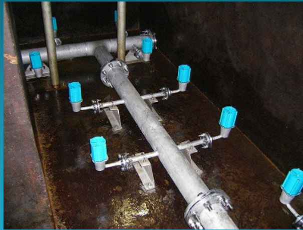
散気管アクアブラスターを設置した状態
