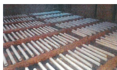
筒形散気管:304本 通気量:40m 3 /min(131.5L/分/本)
