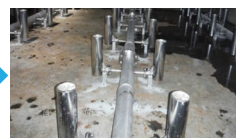
アクアブラスターAL-750:54本 通気量:40m 3 /min→ 34.4m 3 /minに(637L/分/本)
